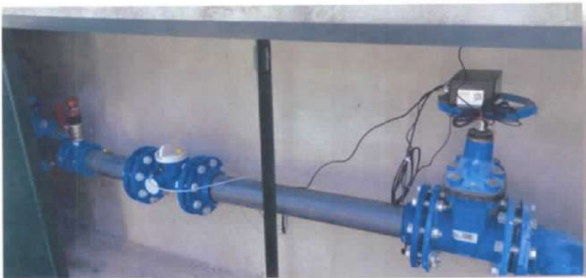
Figura 1 – Exemplo de Zona de Monitorização e Controlo.
